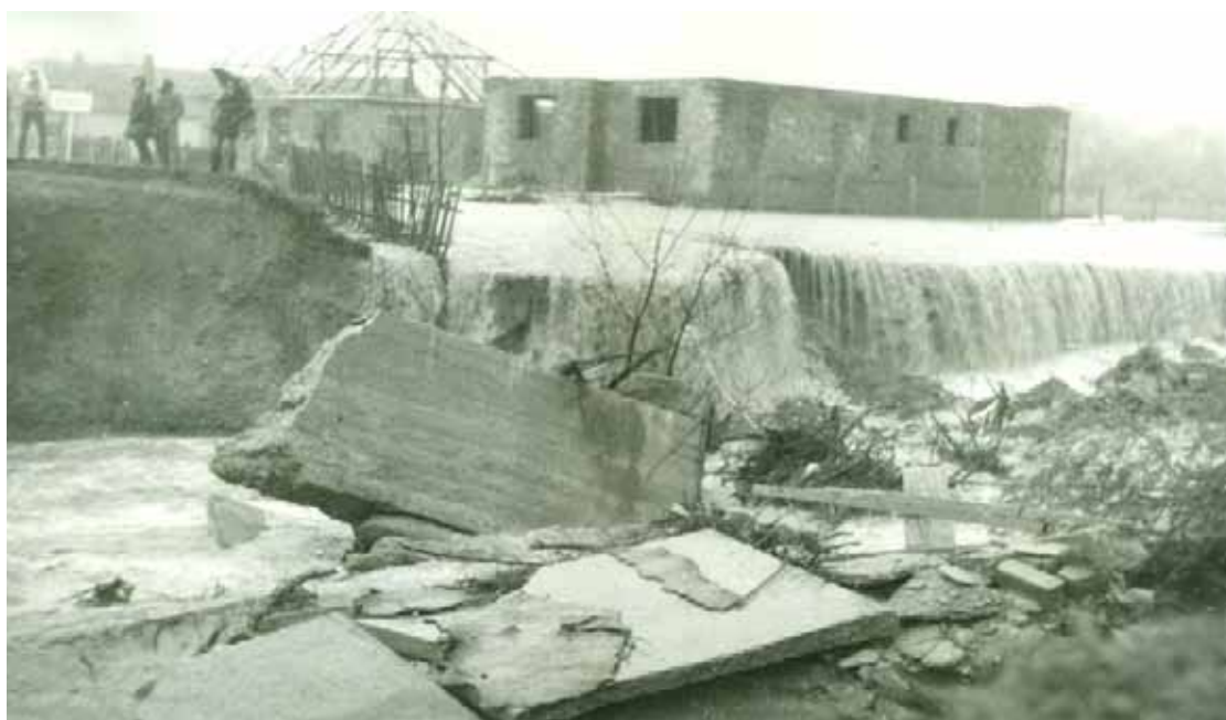
14-16.05.1984 Întorsura Buzăului – pod rupt pe D.N. 10
