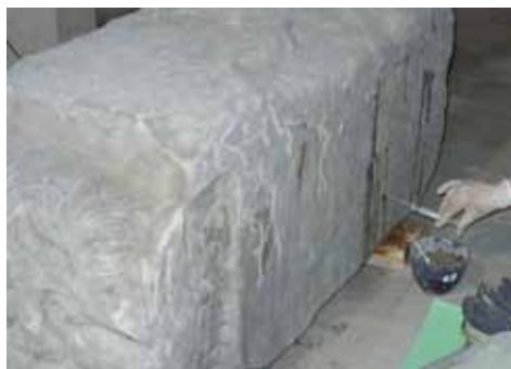
Fig. 9. Injectări cu apă alcoolizată urmată de injectări cu Primal (preconsolidare)
