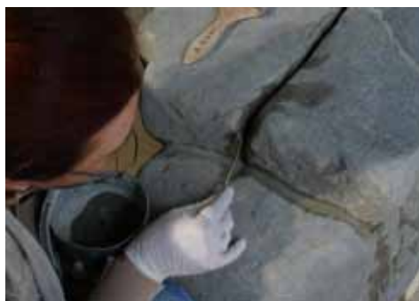
Fig. 8. Chituire sub nivel
