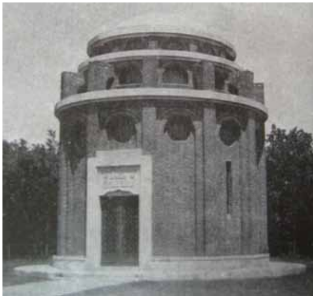
Capela Blank – proiectată de arhitect Duiliu Marcu (foto din arhiva arhitectului)
