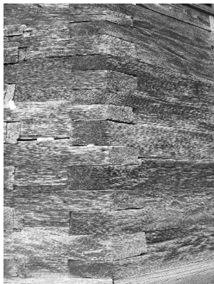
Planșa 4 - Biserica de lemn a schitului Pârvești 1. fațada principală; 2. absida laterală nord; 3. sistem de îmbinare a bârnelor; 4. decor al cornișei
