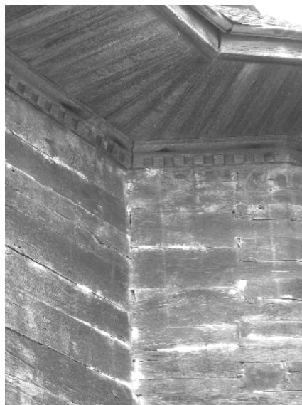
Planșa 4 - Biserica de lemn a schitului Pârvești 1. fațada principală; 2. absida laterală nord; 3. sistem de îmbinare a bârnelor; 4. decor al cornișei
