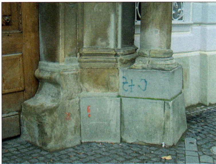
Figure 3. Disaggregating column base from the main gate entrance - photo Drăgușanu. Figura 3. Dezagregarea bazei coloanei de la poarta principală de intrare. Se remarcă corecțiile făcute la soclu – foto Drăgușanu
