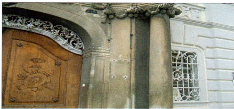
Figure1. Black crust formed on limestone frame main gate, the columns and capital - photo S. Drăgușanu. Figura1. Crustă neagră formată pe ancadramentul de calcar al porții principale, pe coloane și capite – foto Drăgușanu S
