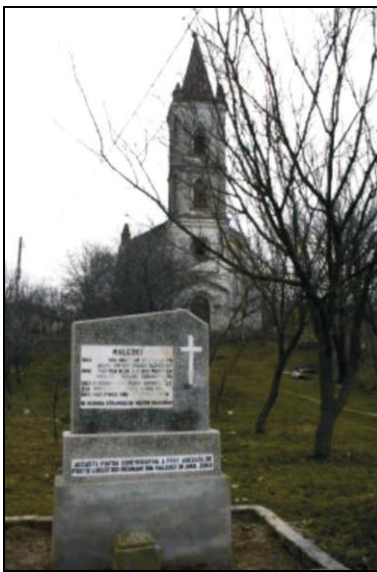
Malcoci. Biserica Catolică, construită de nemți în 1880. Azi într-un stadiu avansat de degradare
