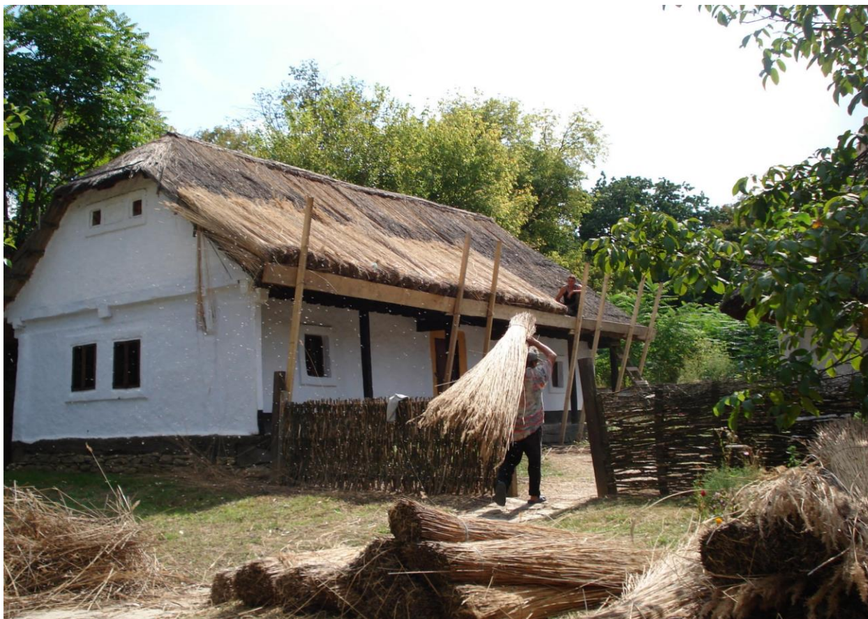
Fig. 5. Reparația învelitorii de stuf la Casa Chereluș (Muzeul ”Dimitrie Gusti”)
