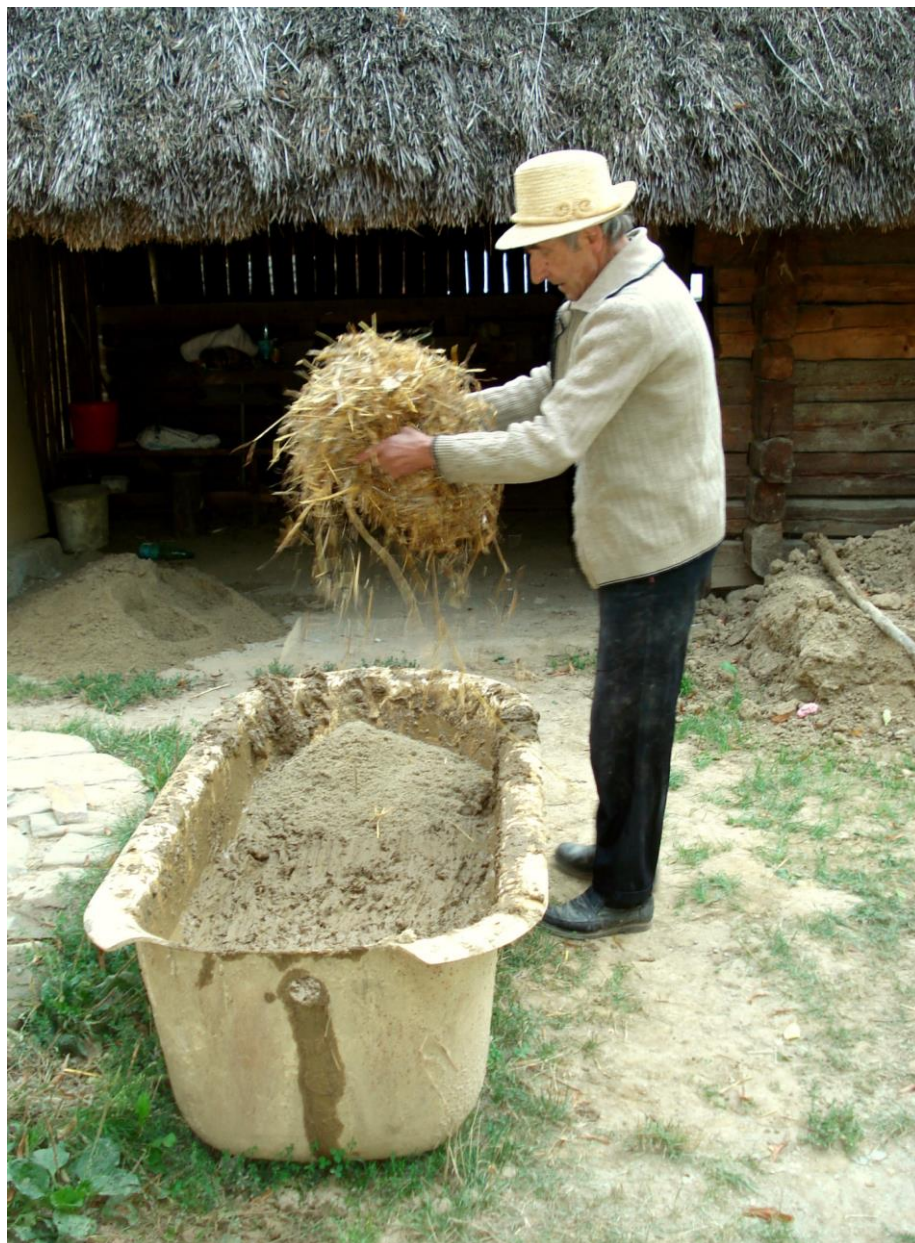
Fig. 7. Pământul folosit la lipirea pereților trebuie amestecat cu paie
