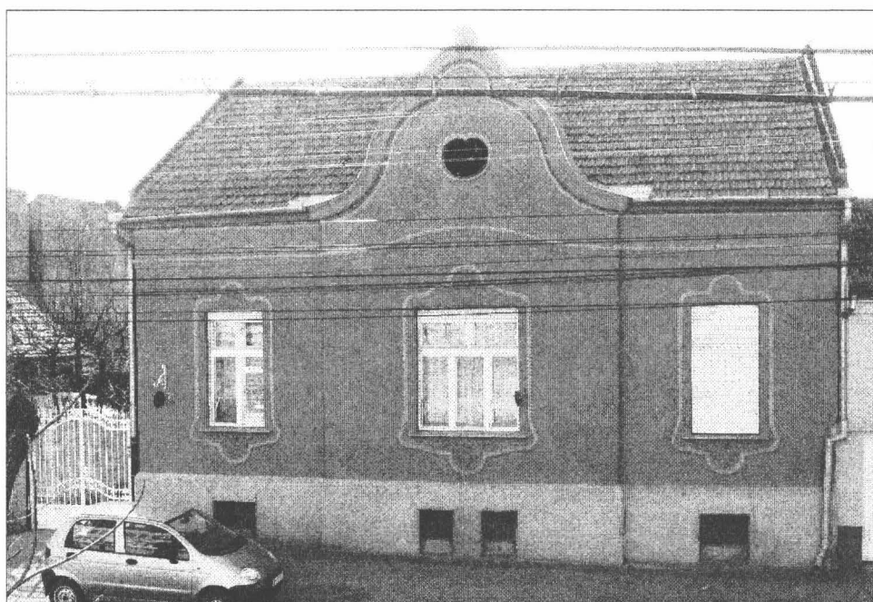
Casa Sáfrány Lajos, imagine actuală.
