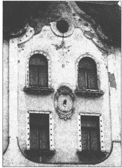
Casa Poinar, detaliu al fațadei.
