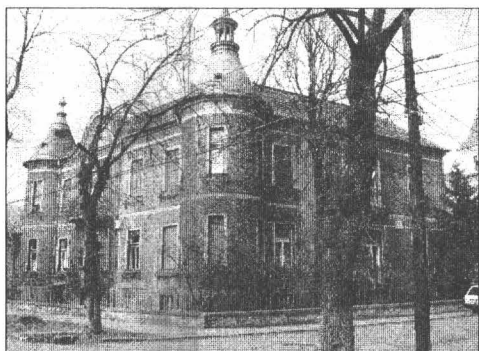
Primul imobil Sztarill de pe str. Pescărușului, imagine actuală.
