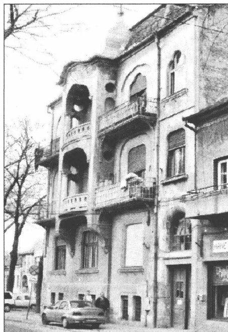
Casa Oláry Gyula, imagine actuală a fațadei
