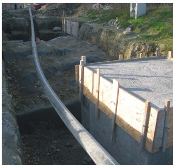
Fig. 7. Zidul de incintă protejat în raport cu lucrările de canalizare pe străzile Turnului (a), Ulmului (b), Cetății (c) și Arheologiei (d)
