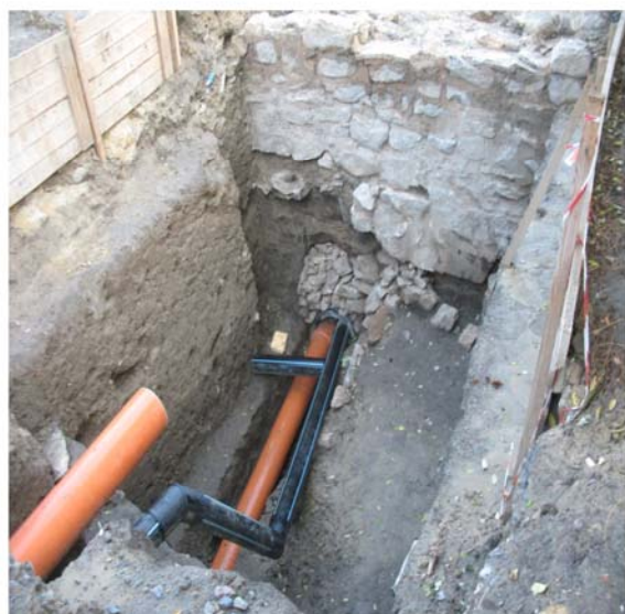
Fig. 7. Zidul de incintă protejat în raport cu lucrările de canalizare pe străzile Turnului (a), Ulmului (b), Cetății (c) și Arheologiei (d)
