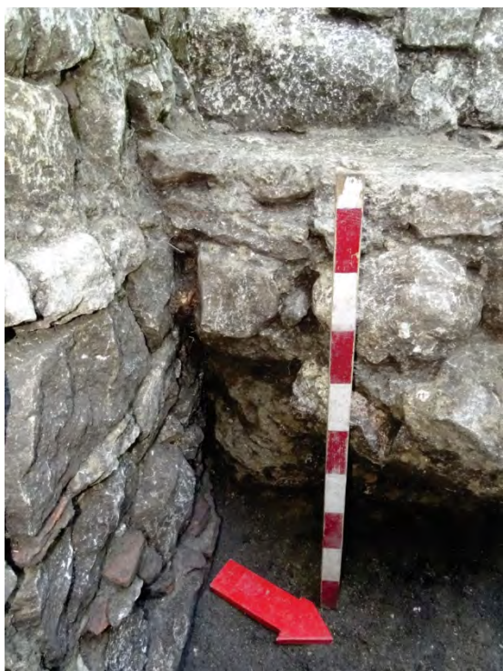
Figura 29. Detaliu cu adosarea fundației celui mai de vest contrafort perpendicular nordic la fundația navei / Close-up with the abutment of the foundation of the westernmost northern perpendicular buttress onto the foundation of the nave.
