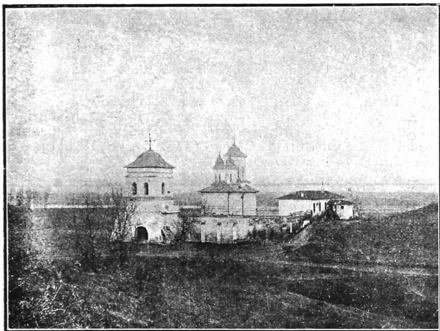
81. M-rea Gura Motrului: vedere generală.
