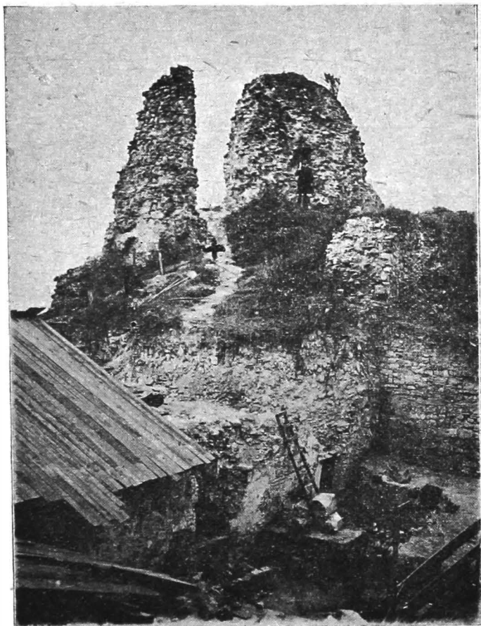
Fig. 6. — Turnul sudvestic înainte de a începe săpătura; jghebul (+) pe care dăm afară dărămătura.
