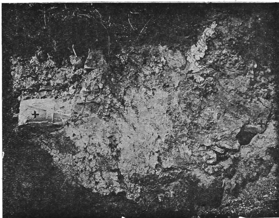
Fig. 7. — În blocul de zid, năruit dela etaj, se observă două pietre cioplite (+).
