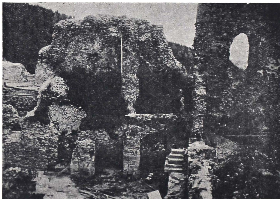
Fig. 53. — Rezultatul săpăturilor în partea răsăriteană (+ arată limita superioară a săpăturilor).
