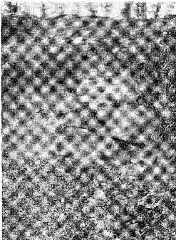
Fig. 24. Porțiune dezvelită din zid de pe „Cetatea Vitial”
