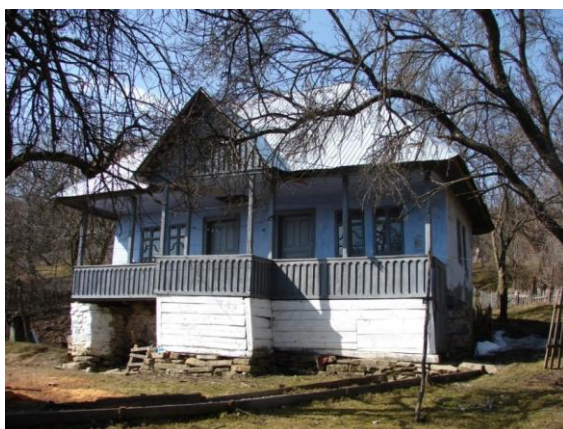
Fig. 8 – Casa Buzdugan Ion, Brădet, 1948, este așezată pe o pîmniță cu zidurile groase, din piatră fasonată, cu sală, foișor dezvoltat în ax și două camere cu intrări separate
