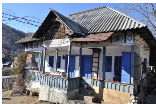
Fig. 6 – Casa Cristescu Ecaterina, Mușătești nr. 64, cca. 1920. Casă cu foișor central, sală pe două laturi și pimniță doar pe camera de la drum. Mărindu-se familia, pe latura din spate, prin prelungirea șarpantei, s-au construit o cameră și o polată deschisă, pentru a satisface cerințele crescânde de spațiu
