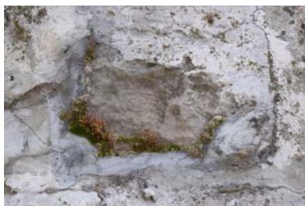
Fig. 1 – degradări biologice
