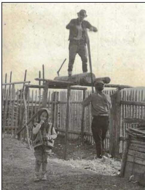
Fig. 21. Confecționarea scândurilor cu beschia la Straja – Suceava (1957)
