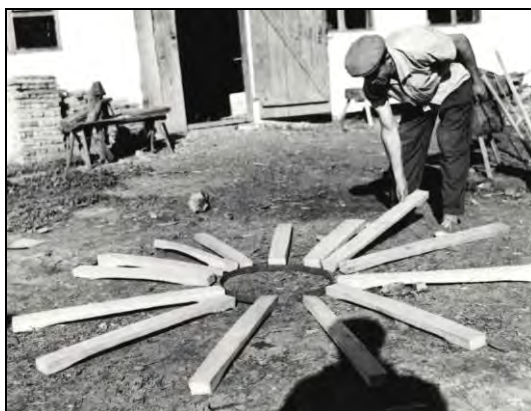
Fig. 5. Înșiratul doagelor la Boghicea – Neamț (1966)
