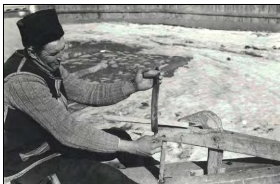
Fig. 4. Trasul doagelor la scăunoaie în Bogata – Suceava (1973)
