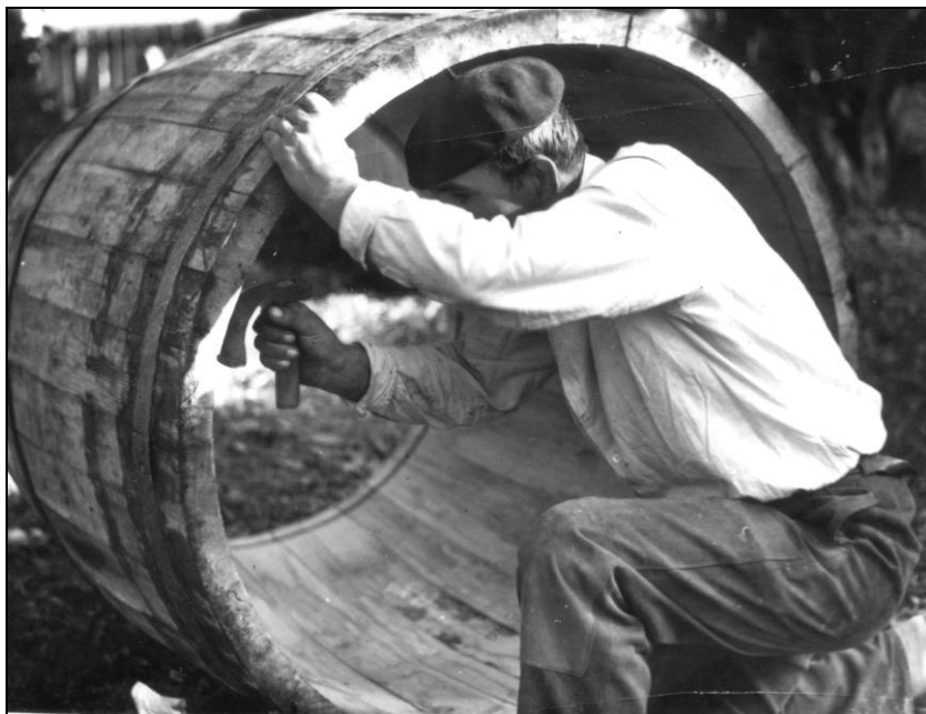
Fig. 29. Tesluitul butoiului la Boghicea – Neamț (1966)
