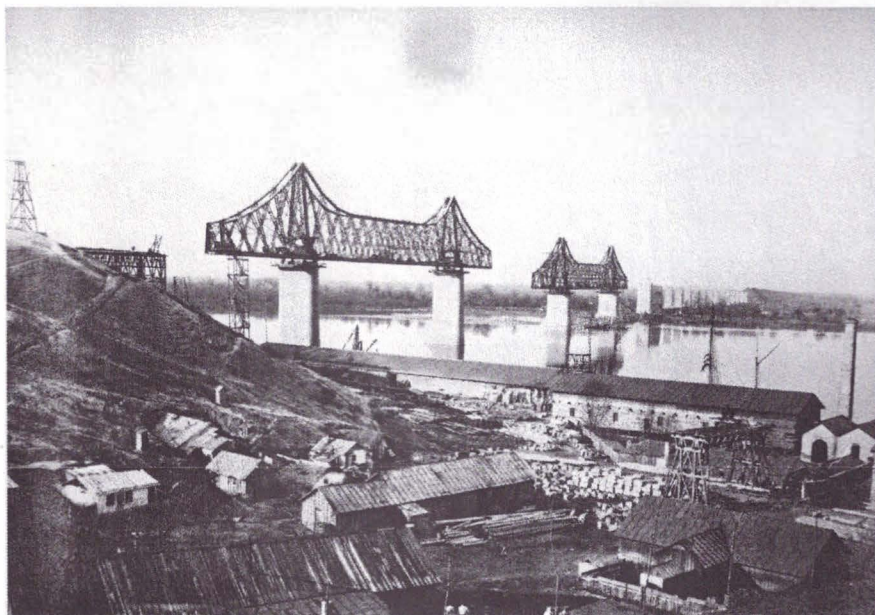
Șantierul podului și fragmentede paliere pe picioare
