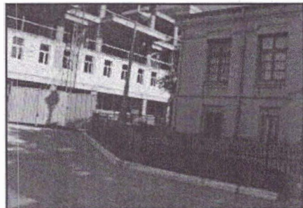
Fig. 15. Bioinginerie – corp anexă
