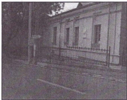
Fig. 12. Fațada de la strada M. Kogălniceanu
