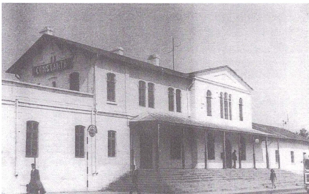
Fațada clădirii Gării C.F.R. spre piața limitrofă.
