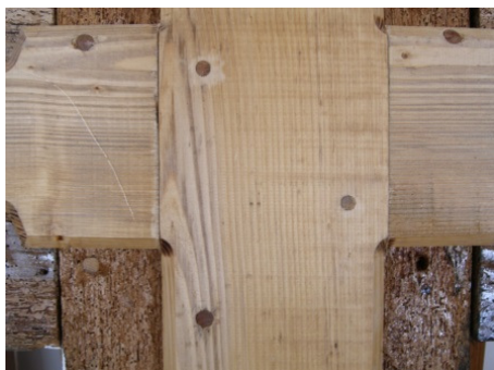
foto 9 Impregnare cu paraloid și consolidarea nou pe revers folosit ca sistem de prindere, diabluri din lemn
