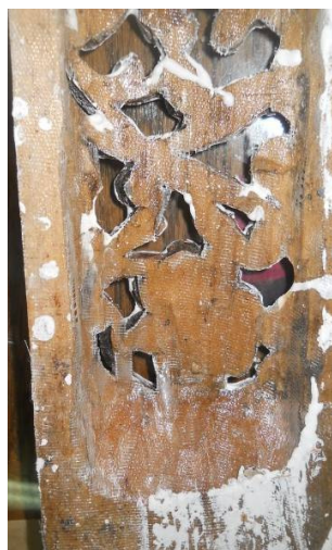
foto 8. Consolidarea unei frize decorative cu paraloid și vâl din fibră de sticlă
