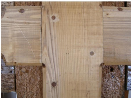
foto 9 Impregnare cu paraloid și consolidarea nou pe revers folosind ca sistem de prindere, dibluri din lemn
