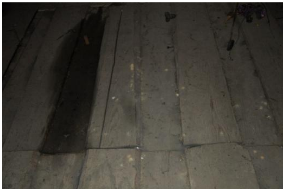
Scânduri ude ceea ce indică faptul că acoperișul permite pătrunderea apei pluviale
