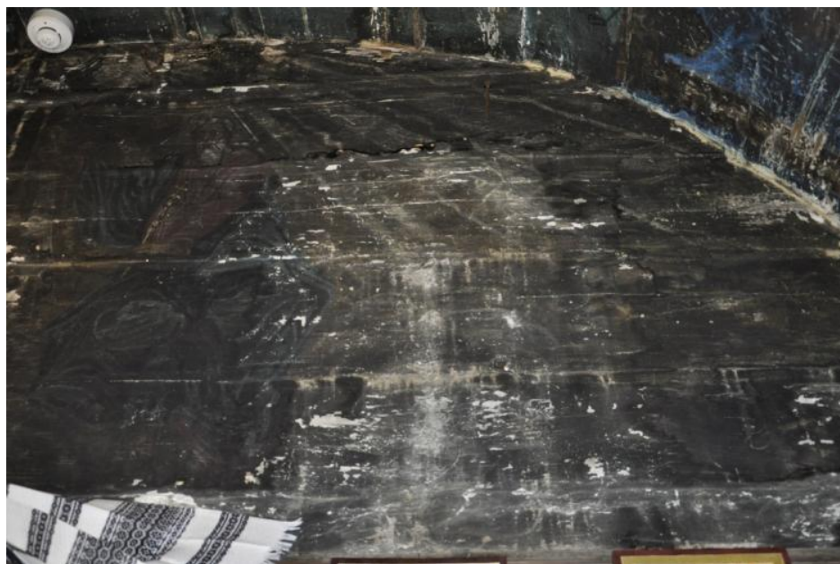
Pierderi ale peliculei de culoare datorate apei care s-a prelins prin spăturile acoperișului
