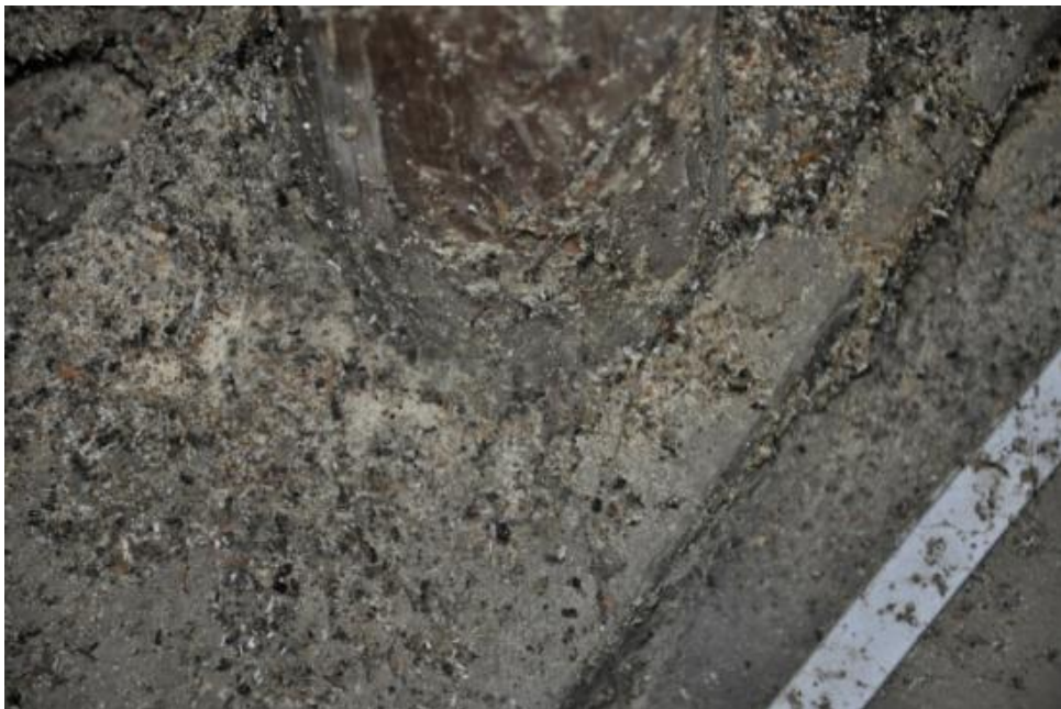
Murdărie aderentă și neaderentă se suprafața lemnului din boltă (fotografie realizată în podul bisericii) - excremente de șoareci, praf, pânze de păianjen, insecte moarte
