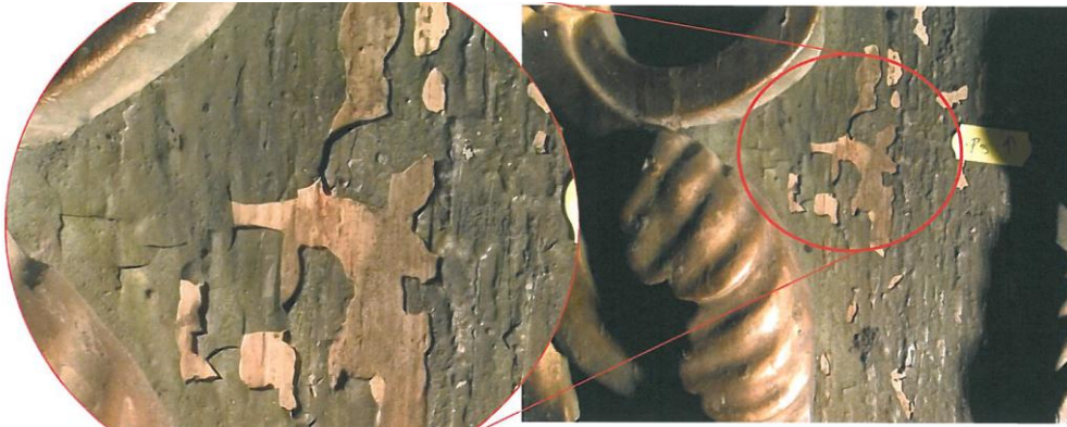
Desprinderi și pierderi ale stratului de preparație și ale stratului de culoare (Ușă Împărătească)
