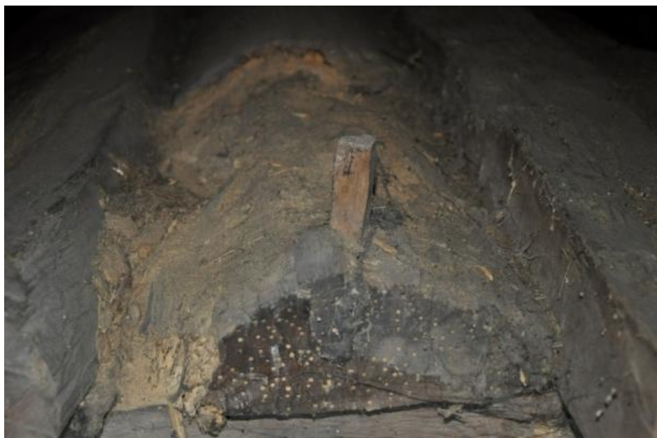
Grindă de la baza boltei (partea de nord), atac xilofag activ, atac fungic
