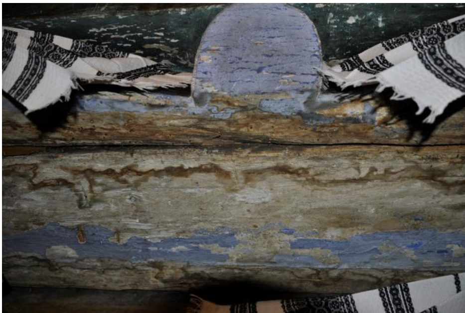
Urme ale umidității provenite de la urina de jder
