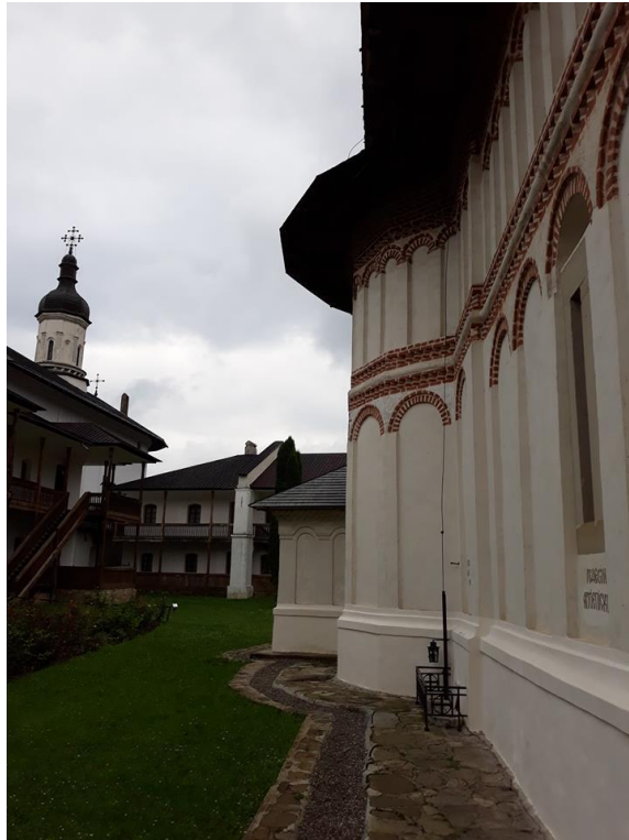
Fig. 2. - Biserica cu hramul "Tăierea Capului Sf.Ioan Botezătorul", Mănăstirea Secu. Vedere pe latura de nord, unde se află mormântul episcopului Ghedeon
