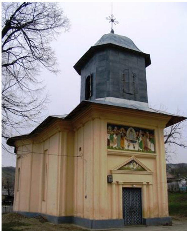
Fig. 2 - Vedere nord-vest - biserică (foto, 2012).
