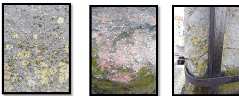
Fig. 2. Atac biologic, cruste negre, licheni, mușchi, fractură, carență material litic.
