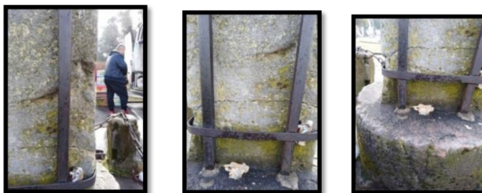
Fig. 3. Atac biologic, cruste negre, mușchi, licheni, depuneri aderente, fracturi, pete datorate oxidării suportului metalic.
