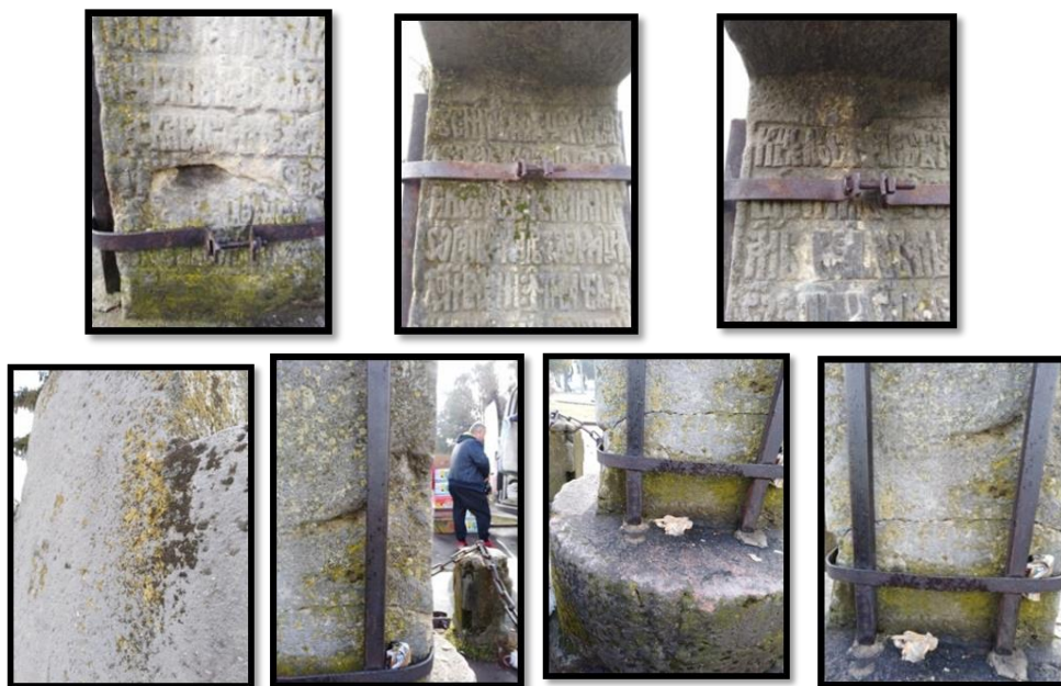
Fig. 4 .Atac biologic, cruste negre, mușchi, licheni, fracturi, pete, scurgeri oxidante datorate suportului metalic
