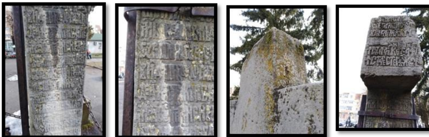
Fig. 1. Cruste negre, erodări de text, exfolieri și zone lacunare. atac biologic, depuneri aderente de mușchi.
