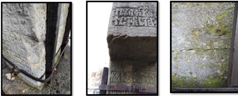
Fig. 7. Datorită fenomenul de îngheț - dezgheț suprafața pietrei prezintă diferite forme de pierdere a coeziunii și adeziunii.
