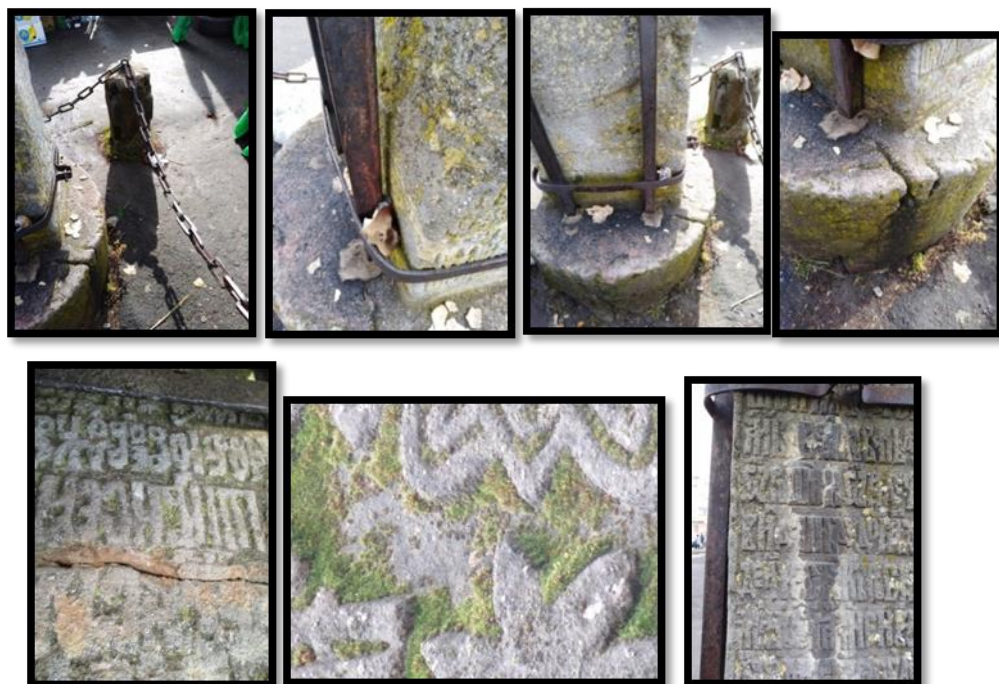
Fig. 10. Atac biologic-alge, licheni în diferite faze de dezvoltare, prezența vegetației-mușchi, plante, eroziunea eoliană – vânt + praf, praf, fisuri, crăpături, dislocări, zgârieturi, ciobituri, spărturi
