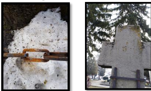
Fig. 5. Zale și suport metalic cu oxizi, zone lacunare, atac biologic - licheni, cruste negre.
