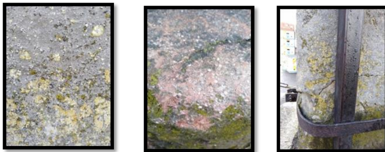
Fig. 2. Atac biologic, cruste negre, licheni, mușchi, fractură, carență material litic.
