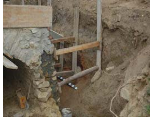
Fig. 16 – cuptorul 1 etapă de lucru
