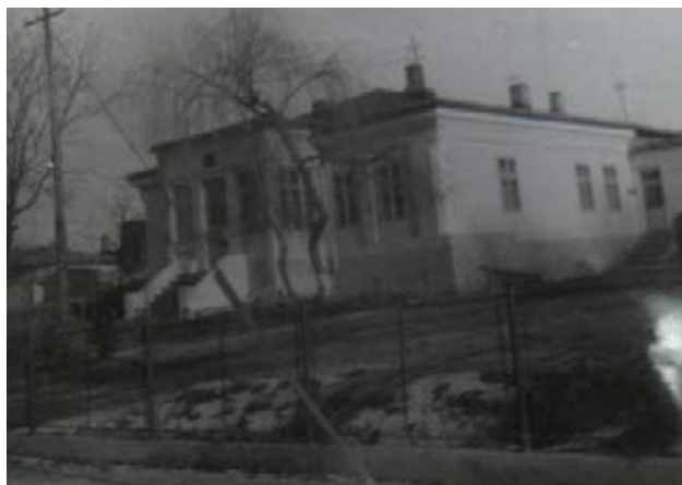
Figura 2. Casa Gaspar Balasan în care a funcționat Școala Comercială Elementară de băieți Botoșani 19
