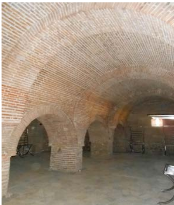
Foto 6. Mănăstirea Măxineni restaurată. Beciul stăreției cu stâlpii din secolul al XVII-lea.
