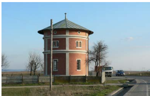
Foto. 3. Castelul de apă de la Săbăoani (Foto: Vieru Paul 2015)
