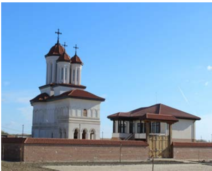
Foto 4. Mănăstirea Măxineni. Biserica și stăreția. Vedere dinspre nord-vest. Se observă zidul de incintă și poarta de pe latura de vest.
