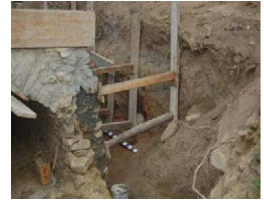
Fig. 16 – cuptorul 1 etapă de lucru
