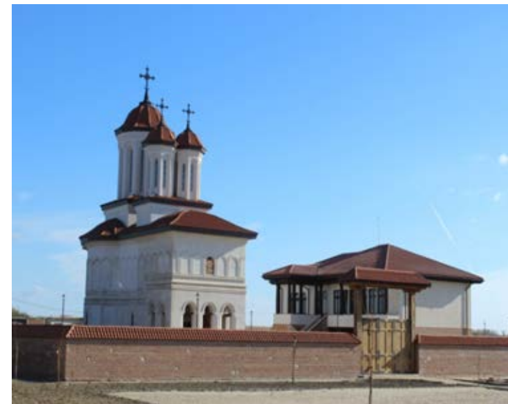
Foto 4. Mănăstirea Măxineni. Biserica și stăreția. Vedere dinspre nord-vest. Se observă zidul de incintă și poarta de pe latura de vest.
