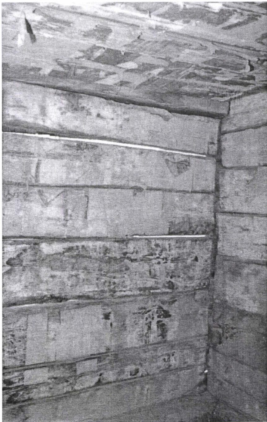
Fig.7. Protejarea picturii din pronaos.
