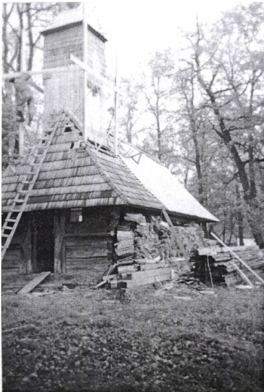
Fig.5. Restaurarea acoperișului turnului bisericii.
