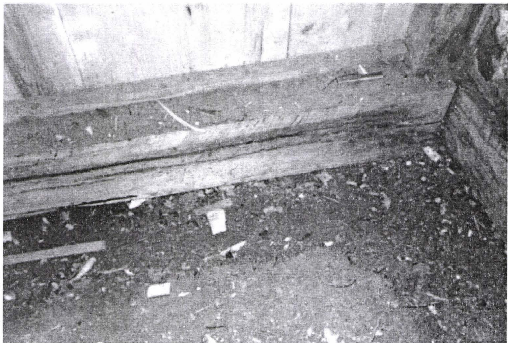
Fig.3. Realizarea șanțurilor – canalelor de aeraj, și curățirea bânelor – tălpoaielor în vederea placării lor cu lemn sănătos.
