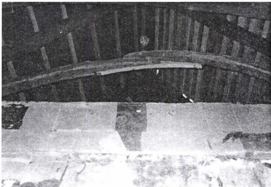
Fig.6. Supradimensionarea arcelor de boltă și acoperirea picturii iconostasului cu foiță japoneză.
