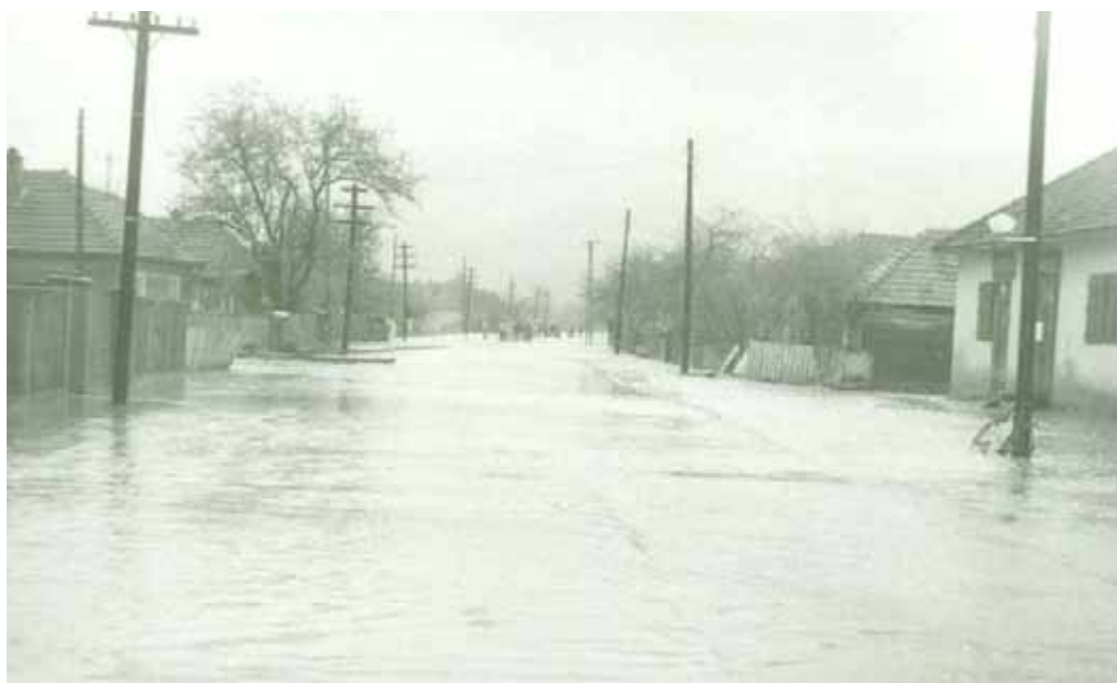
14-16.05.1984 Sita Buzăului DN 10, case inundate de viitura râului Buzău
