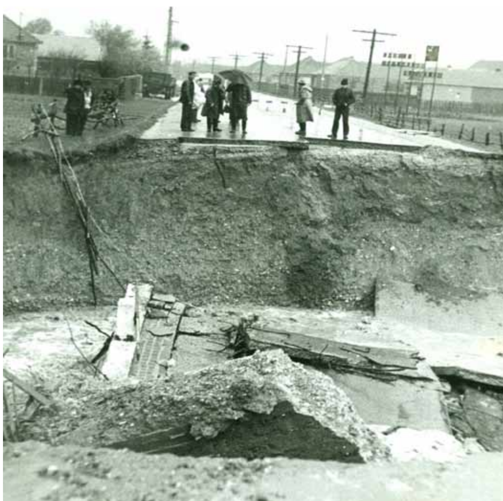
14-16.05.1984 Întorsura Buzăului – pod rupt pe DN 10
