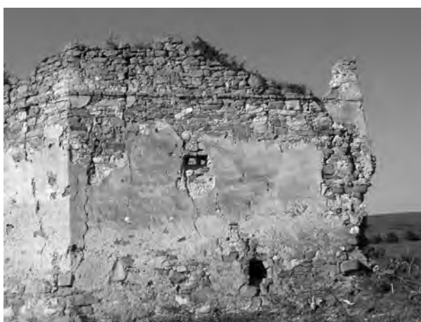
Figura 12 / Figura 12 Latura nord-estică / The north-eastern side.
