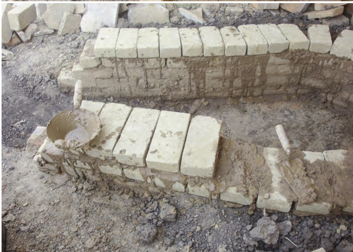
Planșa VII / Plate VII (foto 17-18): Construcția cuptorului 2 / (photo 17-18): Construction of furnace 2.
