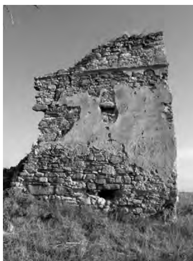
Figura 10 / Figure 10 Latura sudică / The south side.
