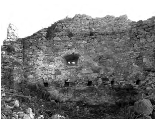
Figura 14 / Figure 14 Locașurile de bărne ale etajelor / Bay beams of floors.
