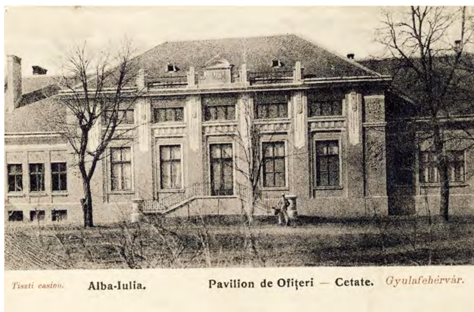
Fig. 5. Cazinoul ofițerilor din Alba Iulia, fațada estică.
