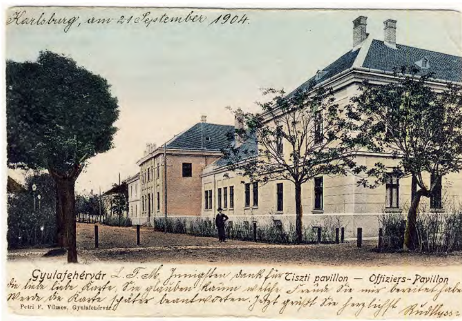
Fig. 4. Cazinoul ofițerilor din Alba Iulia, fațada vestică.
