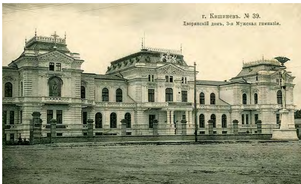
Fig. 19. Clădirea unde au avut loc ședințele Sfatului Țării.
