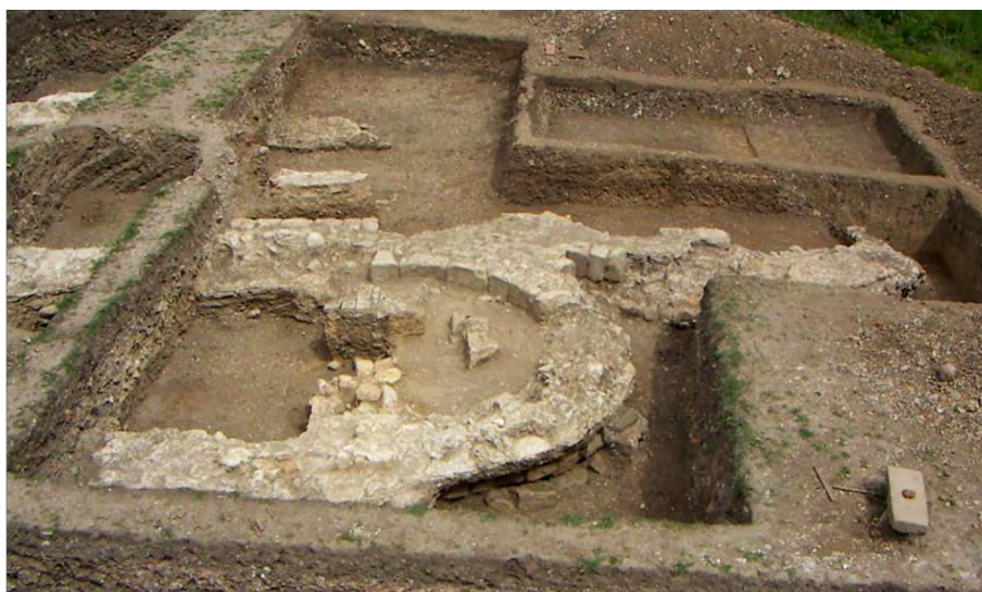
Abb 5. Durch Wassererosion verursachte Schäden an der Haupt- und Nordapsis der Basilika von Bizere (Bild: Florin Mărginean).
