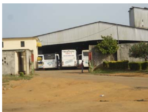
Fig. 2. Un garage mécanique installé sur un ancien cimetière abandonné à Bonoua.
