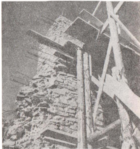
Fig. 5. Cetatea Poenari. Aspect de șantier — restaurare latura de sud-vest
