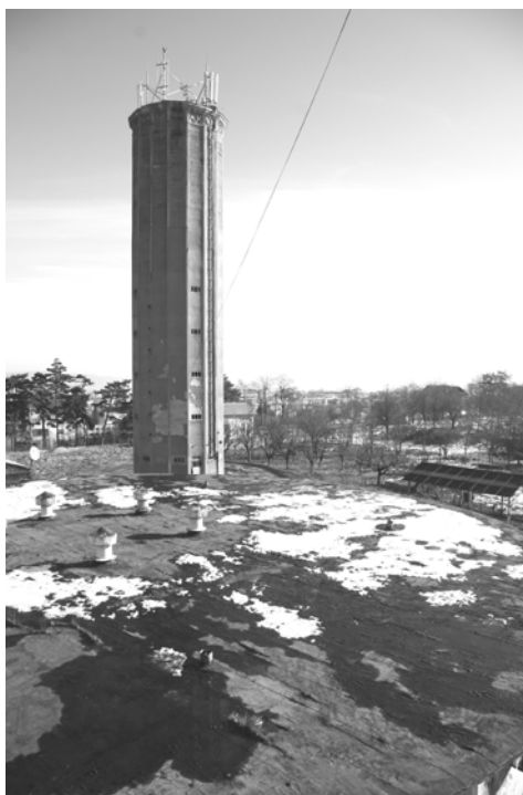
Fig. 3. Rezervorul de apă din cartierul Trivale.
