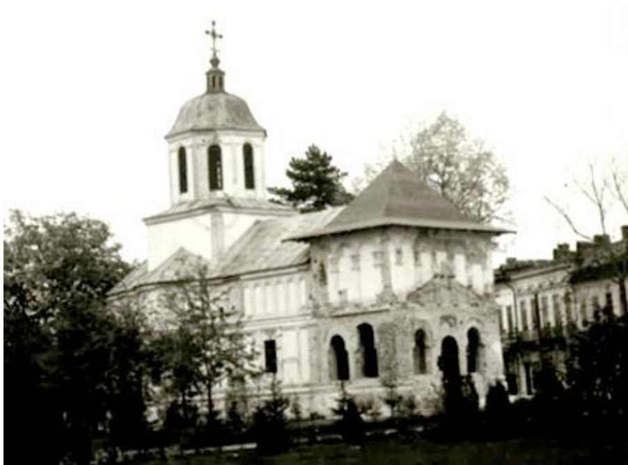
Biserica Domnească din Pitești în timpul restaurării (1963-1968). Foto, arh. Ștefan Balș. Sursa: arhiva I.N.P., fond D.M.I., dos. 7045 bis.
