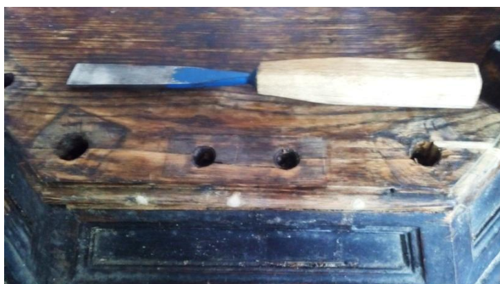
Fig. 3. Remedierea intervenției inadecvate.
