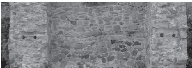
Pl. VI. 1. Ruinele turnului-locuință nr. 1 (foto Al. Szentmiklosi 2006); 2-3. Urmele bânelor din em- plecton și a grinzilor transversale de susținere a planșelor. Abb. VI. 1. Turmhaus Ruinen (foto Al. Szentmiklosi 2006); 2-3. Balken spuren aus em- plecton und an Querbalken die unterstützen der Deckeen.
