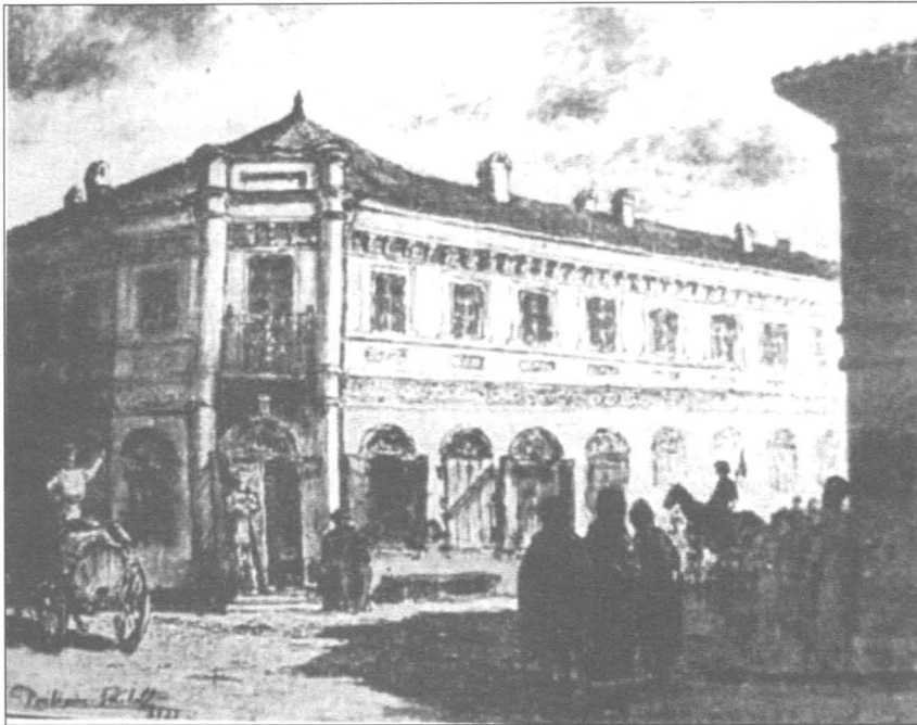
Primul sediu al Agiei – „Casa lui Păun Ișlicarul“ (1812) de pe Podul Târgului de Afară (Calea Moșilor), la intersecția cu ulița Bazaca (azi I.C. Brătianu)
