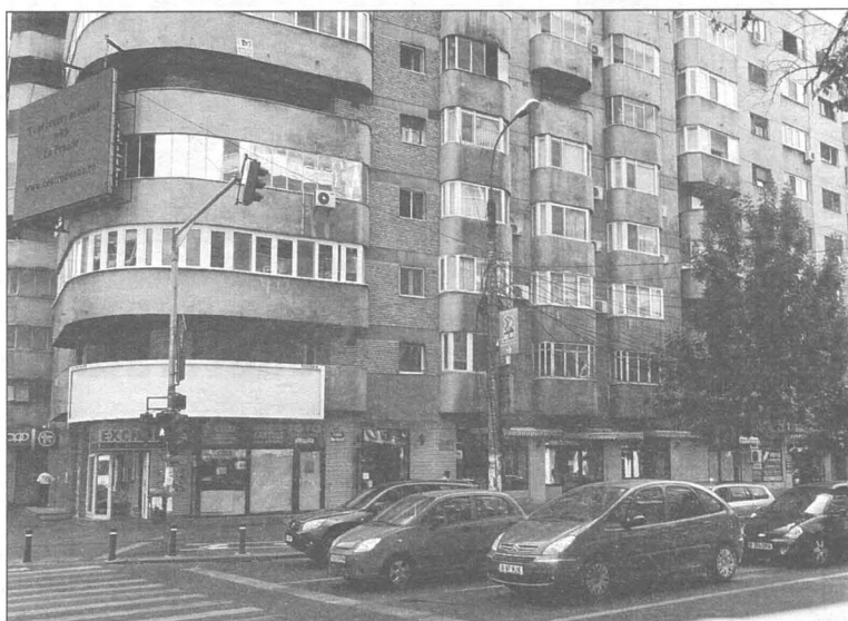
Imobilul ce adăpostește, la parter, expoziția temporară a colecționarilor bucureșteni
