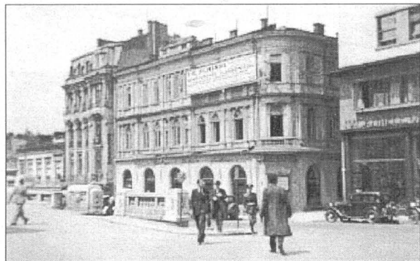
Str. Campineanu coborând din Piața Teatrului, iunie 1937. Berăria Gambrinus (cea originală), gata de demolare. Imobilul construit pe locul ei există și azi. Foto: Victor Potra
