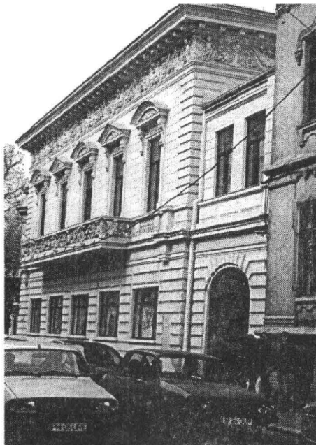
1. Fațada casei dinspre str. C. A. Rosetti.
