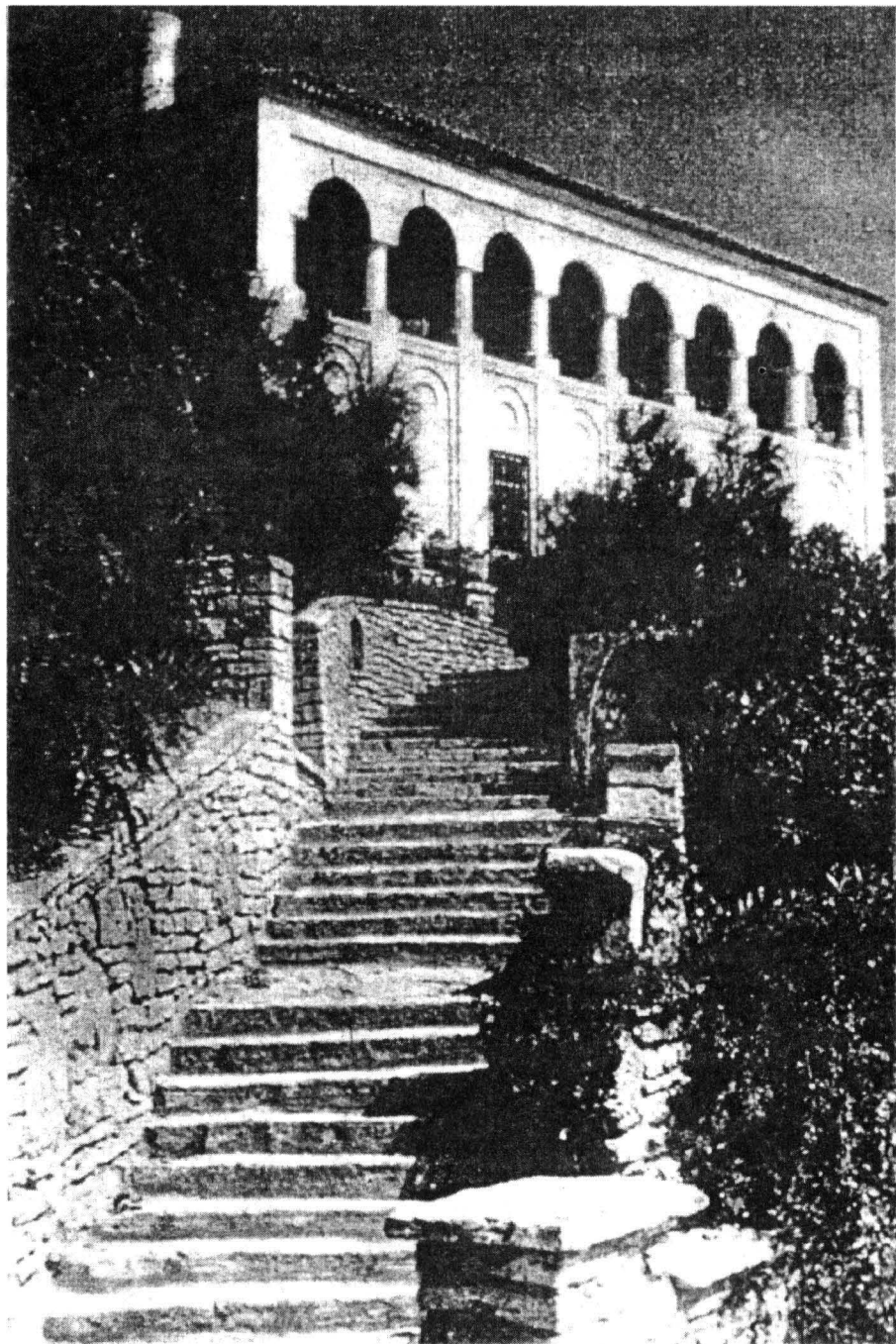
Casa Storck de la Balcic. Fațada spre mare
