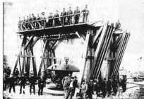
Foto.8: Montarea unei cupole „Gruson” pentru obuzierul de 210 mm fabricată în Germania la Gruson Werke din Buckau-Magdeburg.
