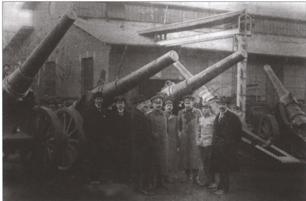
Tunuri „Krupp” md. 1891, cal. 150 mm de la Cetatea București montate pe afeturi realizate în 1916 de Uzinele Vulcan din Capitală
