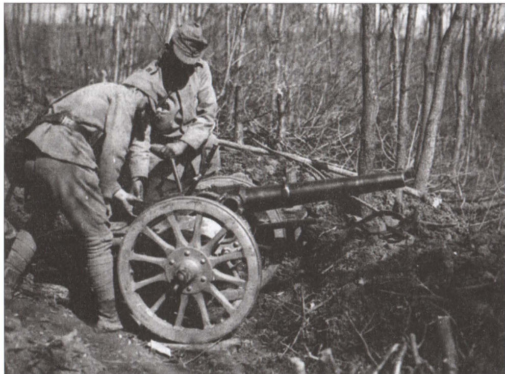
Tun de infanterie realizat prin montarea unei țevi „Gruson” md. 1887, cal. 53 mm, folosit la fortificațiile de la Focșani-Nămoloasa-Galați, pe un afet realizat în Uzinele Lemaître în 1915-1916
