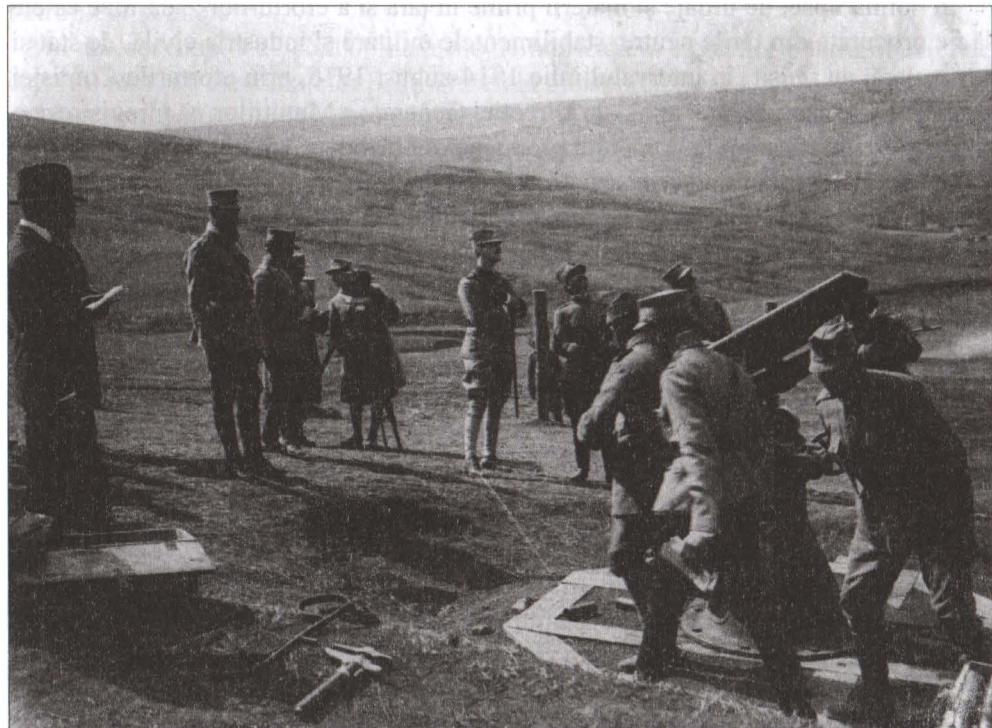
Principele moștenitor Carol asistă la experimentare unui tun antiaerian realizat prin montarea pe un afet cu pivot tip „Burileanu” a țevii unui tun cu tragere repede „Hotchkiss”, md. 1891, cal. 57 mm de la Cetatea București
